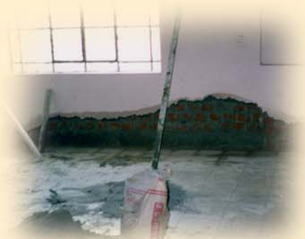
Begin van de verbouwing van Casa Esconi
